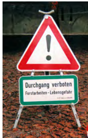
Abb. 72 Beispielhafte Absperungen: geeignete Sperrmittel sind mit der zuständigen Behörde abzustimmen. Soweit der öffentliche Verkehr betroffen ist, müssen die straßenverkehrsrechtlichen Bestimmungen eingehalten werden. Treffen Sie rechtzeitig die erforderlichen Absprachen, z. B. mit Polizei, Straßenverkehrsbehörden, Bahnverwaltung, Energieversorgungsunternehmen.
